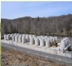
美國Connecticut Yankee 核電廠乾式貯存設施
