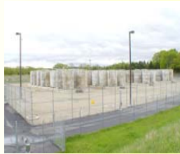
美國Maine Yankee 核電廠乾式貯存設施
